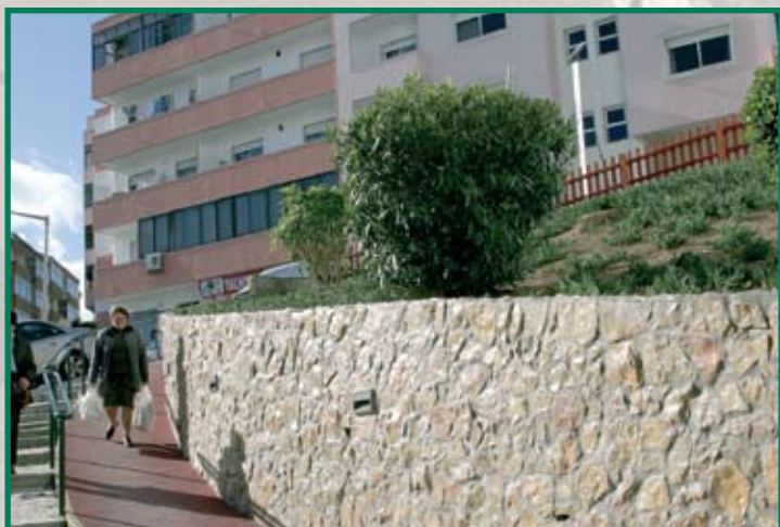
Requalificação da Curva na Rua da Liberdade, Bom Sucesso – Além do embelezamento do muro, procedeu-se à construção de rampa com corrimão e calçada desnivelada.
