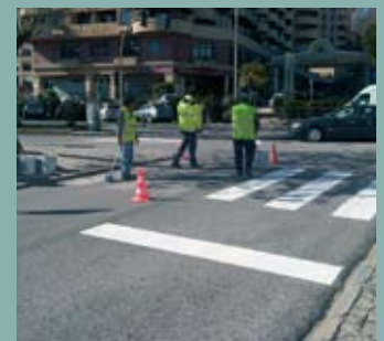
Pintura de passadeiras
