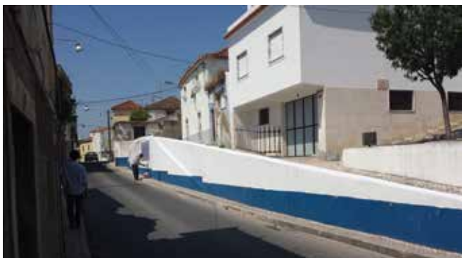
Rua Dr. Miguel Bombarda, importante ponto de passagem na freguesia, com pintura renovada
