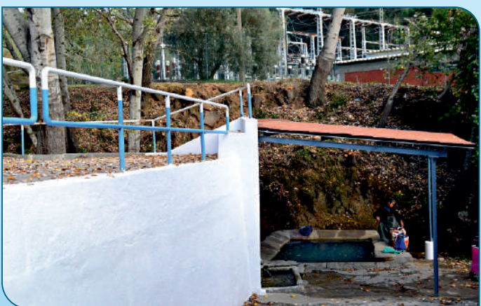
Requalificação do telheiro nos lavadouros no Sobralinho. Pintura do muro em seu redor.
