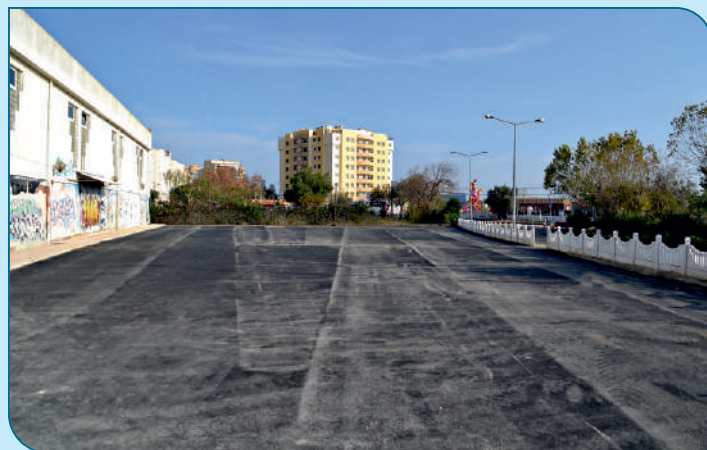
Requalificação do espaço lateral do Pavilhão Municipal com construção de novo parque de estacionamento.
