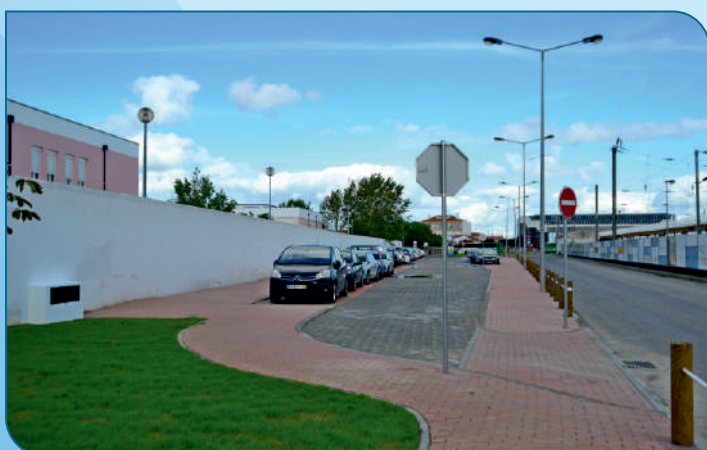
Construção de parque de estacionamento a tardoz da Escola Pedro Jacques de Magalhães com capacidade para 52 lugares.
