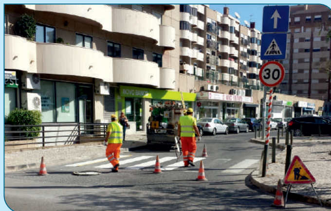
Pintura de Passadeiras ao longo de toda a freguesia.
