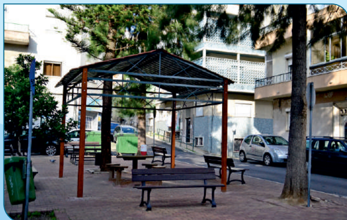
Colocação de um abrigo e mobiliário urbano no Largo da Rua José António do Carmo (antigo largo dos CTT), com vista a proporcionar espaços de estar e lazer à população.
