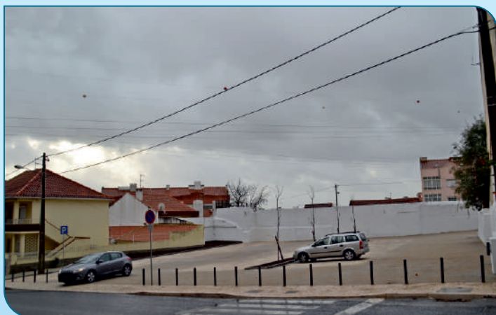
Conclusão das obras do parque de estacionamento no antigo Pátio do Silvino no Bom Sucesso.
