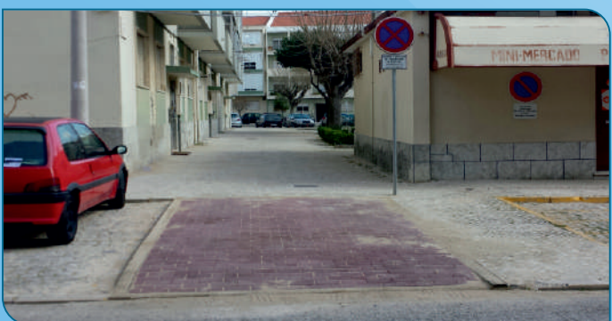
Construção de acesso a veículos de emergência e transporte de doente à Praceta nº 2 da Quinta das Drogas.
