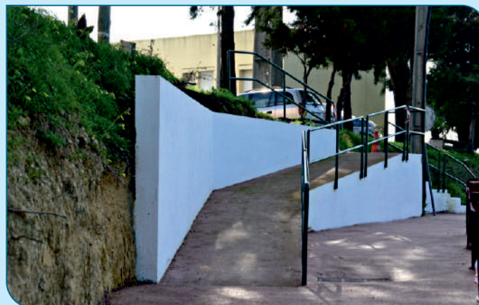
Construção de Rampa no aceso ao caminho pedonal da Rua Sr a da Graça.
