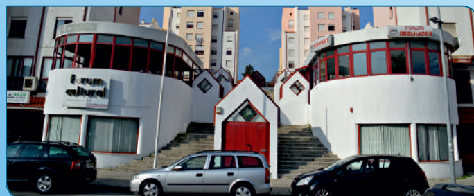
Pintura e restauração do exterior do Fórum da Chasa.
