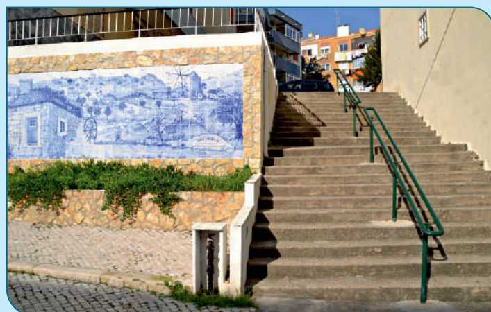
Colocação de corrimão na escadaria da Praceta José Régio para a Rua Soeiro Pereira Gomes no Bom Sucesso.
